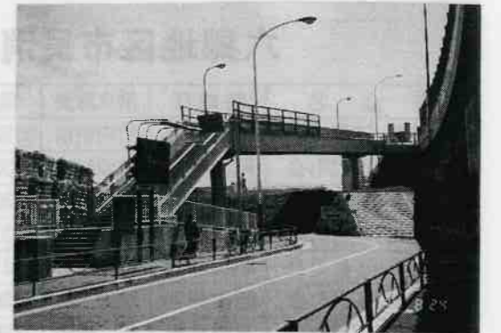
不便ないまの歩道橋
