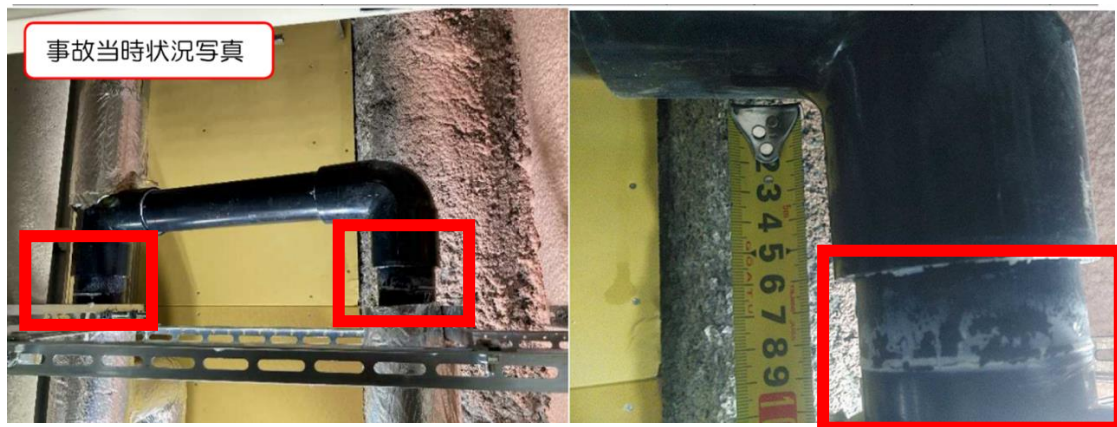
(写真 2.1) 配管接続部の状況 (左：遠景、右：近景)
