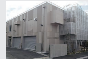
田園調布水防センター
