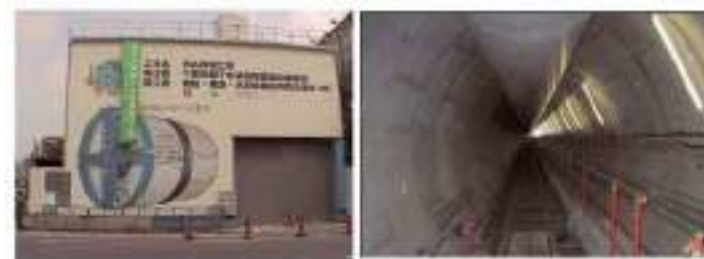
幹線工事(出典 呑川流域豪雨対策計画 東京総合治水対策協議会)
