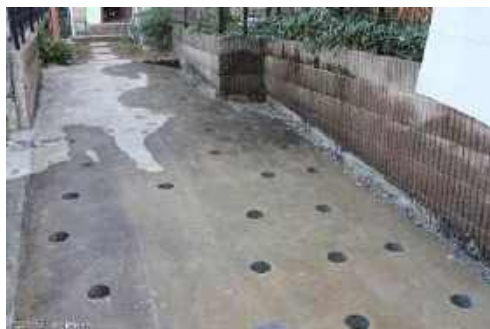
▲杉並区の宅地内の雨庭【出典：NHK Web サイト】
