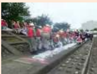
積土の工法訓練
