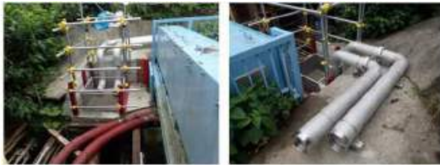
上沼部排水樋管設備改修工事(出典 令和2年度水防態勢の強化について 大田区)
