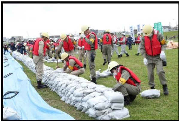
積土のう工法
