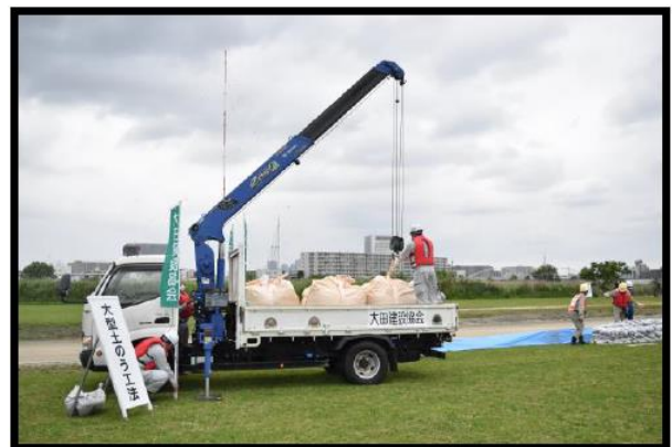
大型積土のう工法
