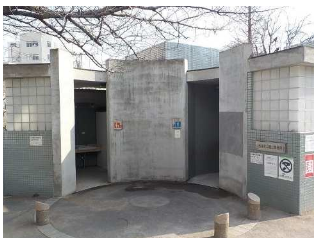
公園トイレ全景
