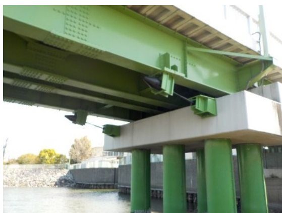
大森東避難橋 昭和47年竣工
