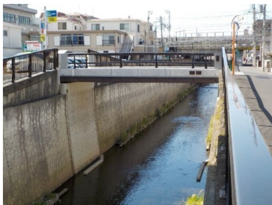
芹ヶ谷橋 昭和45年竣工
