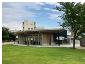
公園施設の利活用の推進 (森ヶ崎緑華園管理棟)
