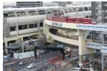
京浜急行線連続立体交差事業※
