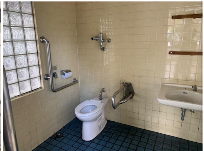
④誰でもトイレ(洋式)
