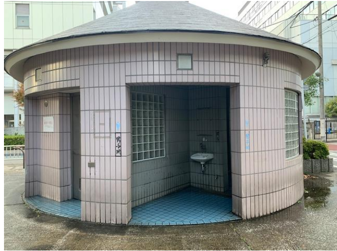
①公園トイレ全景
