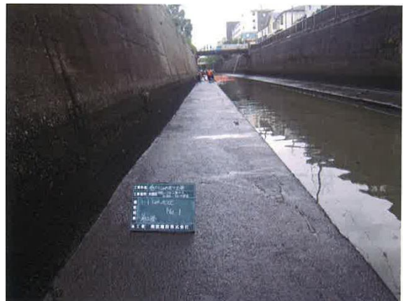
写真 2. 12 施工後写真（一本橋上流側）
