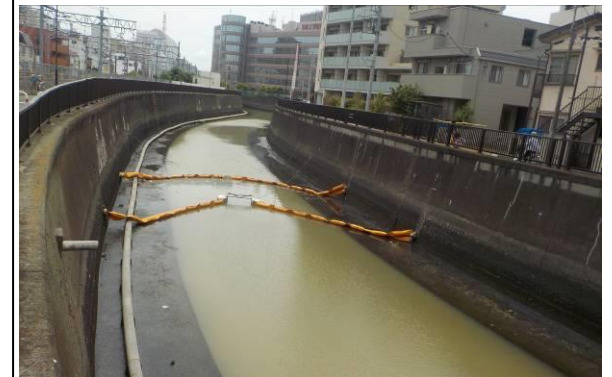
写真 2.2 放流管配管状況
