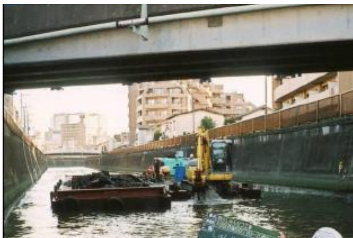
写真 2.4 河床整正施工状況
