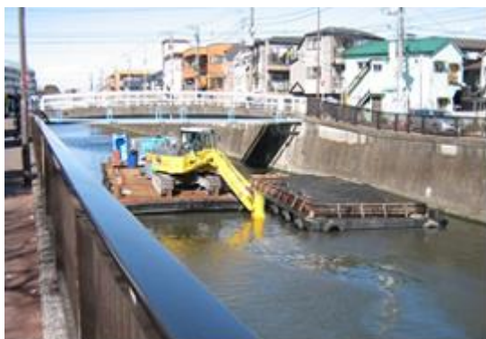
写真 2.5 バックホウによる浚渫状況
