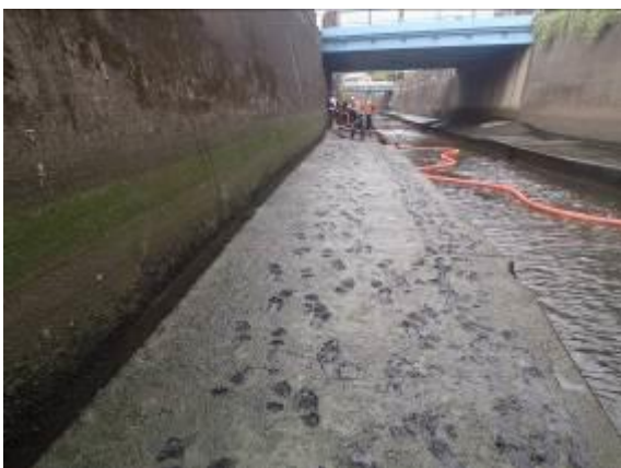
写真 2. 11 施工前写真（一本橋上流側）
