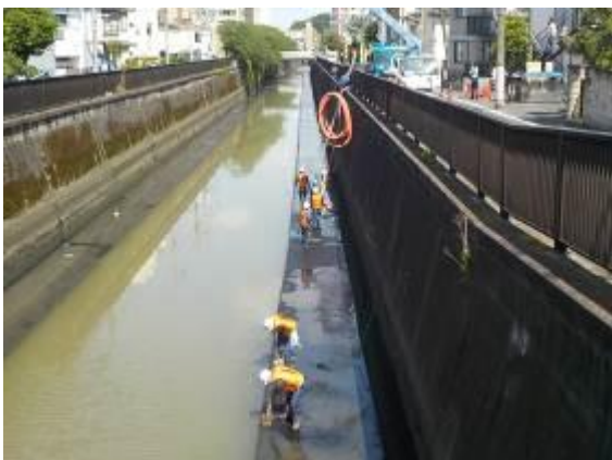
写真 2. 9 施工状況写真（遠景）
