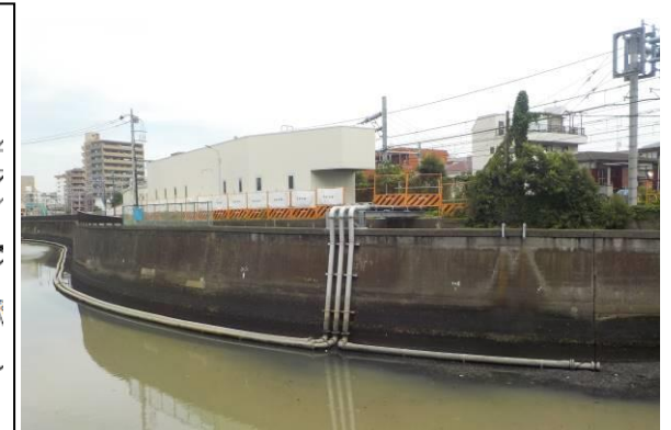
写真 2.1 高濃度酸素水浄化施設全景
