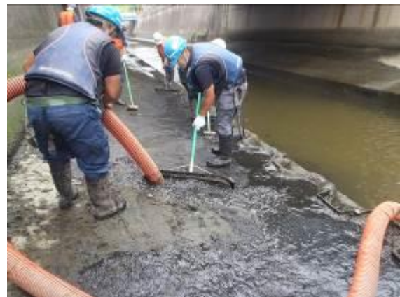
写真 2. 10 施工状況写真（近景）
