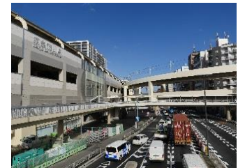
京浜急行連続立体交差事業の高架化
