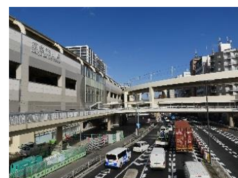
京浜急行連続立体交差事業の高架化
