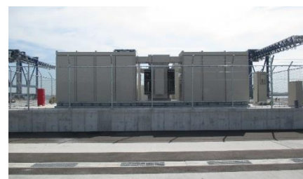
図 53 電源設備の嵩上げ
