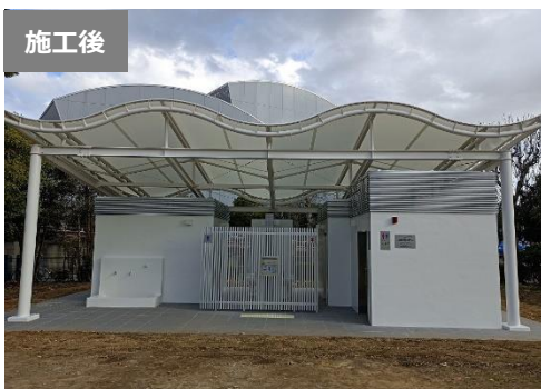
トイレの洋式化、バリアフリートイレの設置
