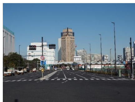
図 52 臨港道路の無電柱化
