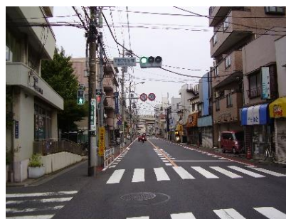
羽田バス通り（無電柱化部）
