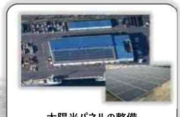
太陽光パネルの整備
