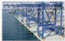
耐震強化岸壁・免震クレーン
