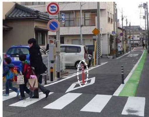
[ボラードが上昇した状態]
