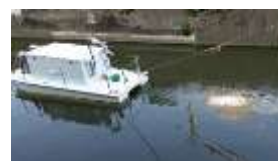
スカム発生抑制装置全景
