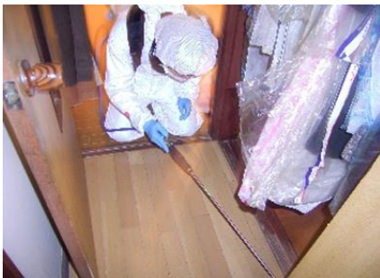
令和元年台風第19号 協会による区内の浸水被害 家屋の消毒作業
