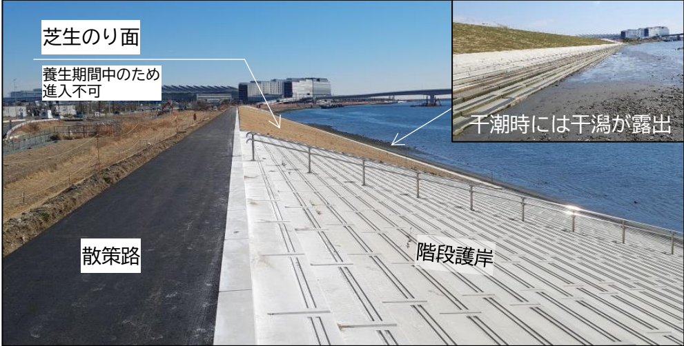
高潮堤防現況写真（上流側から下流側を望む）
