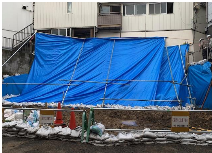
緊急安全措置の状況
