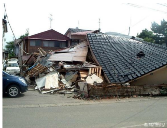
[木造住宅の倒壊]
