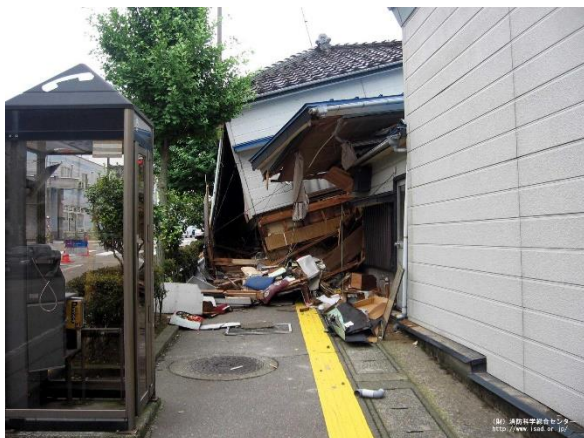
[木造住宅の倒壊による道路閉塞]
