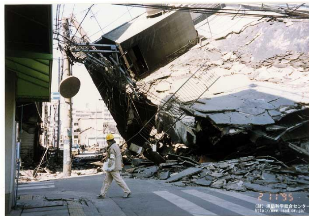
[建物倒壊による道路閉塞]
