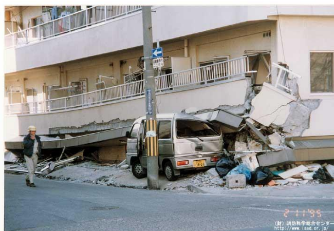
[マンションの倒壊]
