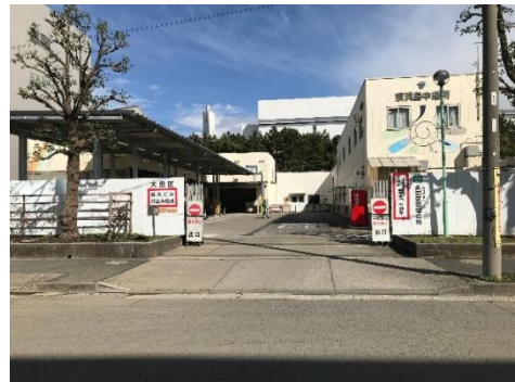
環境資源センター(京浜島)
