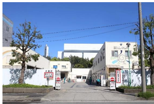
環境資源センター(京浜島)
