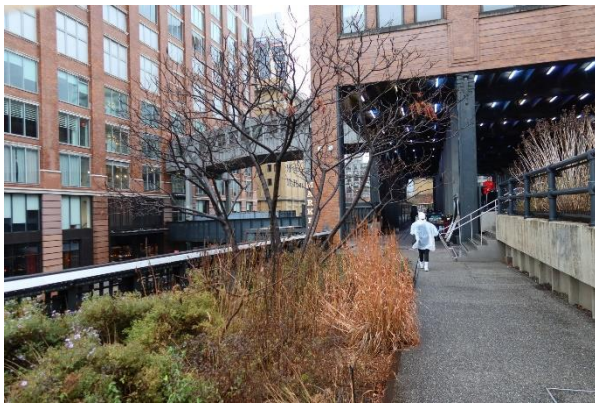
建物の間を通るハイライン
