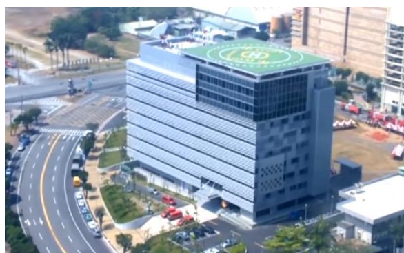
ヘリポートのある高雄市消防局 災害応急センターの外観
