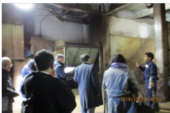
生ごみ二次発酵槽
