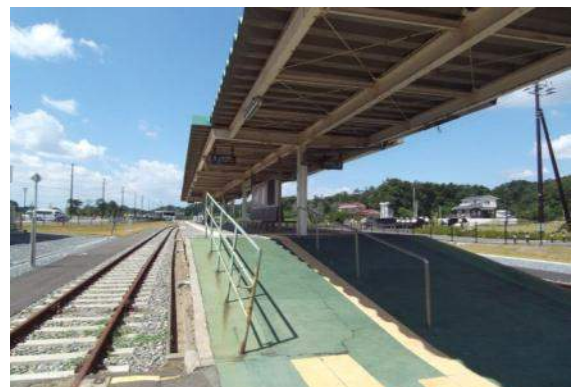
旧野蒜駅プラットフォーム（震災遺構）
