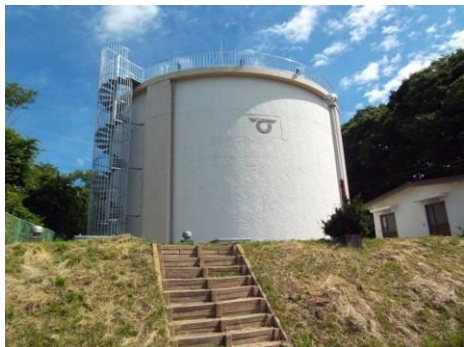
市内最大級の規模の配水池 (容量は3,000立方メートル)
