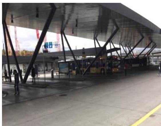
右が空港出口、左が市内へ向かうバスと路面電車の停留所
