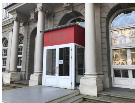
レジデンツ入口 (工事中)
