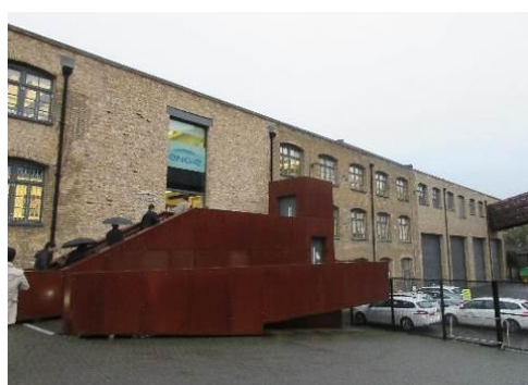
エネルギーセンター
