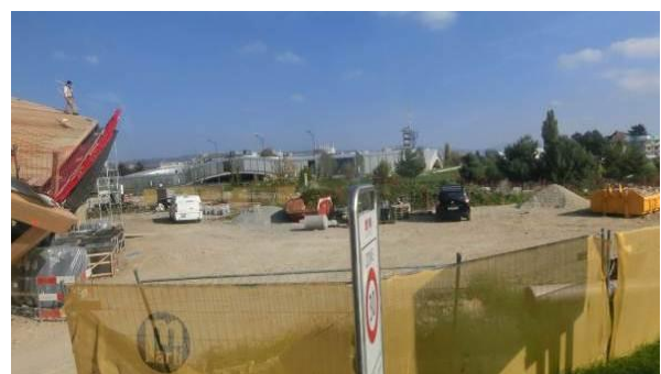
建設中のデジタルカルチャーラボの様子
