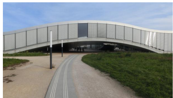
ロレックスラーニングセンター (外観)
