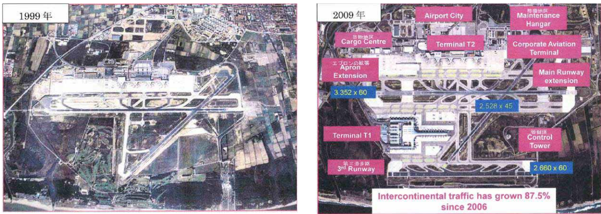
エル・プラット国際空港の旅客ターミナル拡張工事（10年間の比較）
