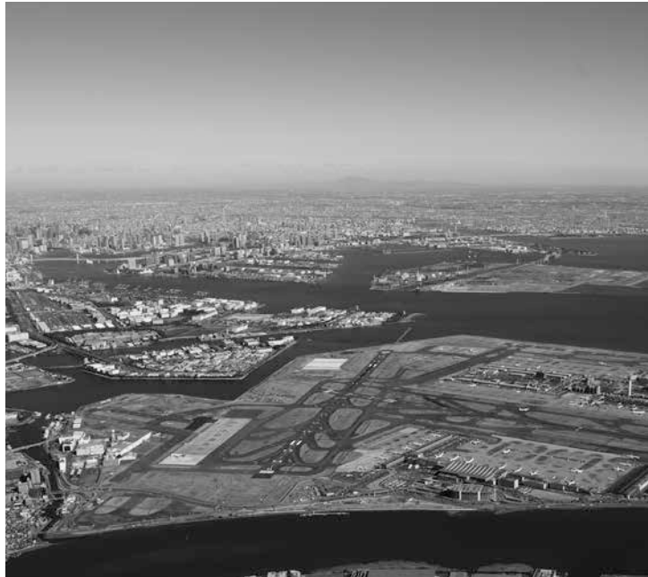
写真は、大田区の空港臨海部。平成29年度は、羽田空港跡地第1ゾーンの整備の新たなステップとして、第1期事業予定地の整備・運営事業者を選定し、成長戦略拠点の整備がスタートするなど、跡地整備は具体化に向けて大きな一歩を踏み出す。
