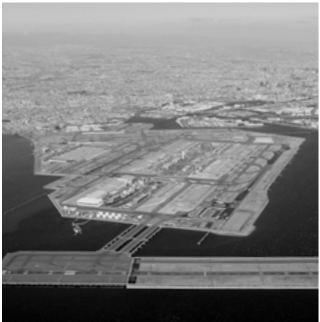
区は、羽田空港の再拡張・国際化に伴う空港臨海部における土地利用の変化などを見極めつつ、円滑な交通の流れとなるよう新たな道路網の整備に取り組んでいる。
