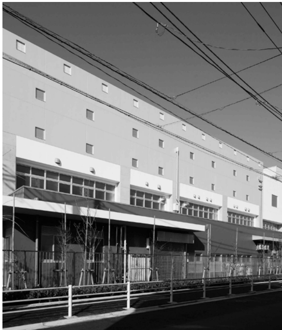
写真は、25年に新校舎が完成した嶺町小学校。学校の改築・改修は、多額の財政負担を伴うため、重要な課題とされている。
