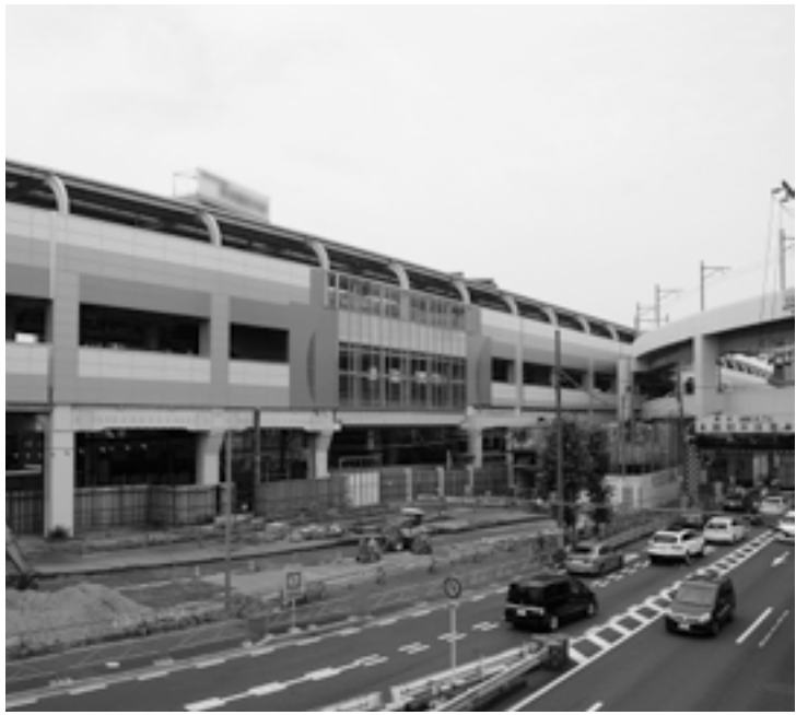
京急線連続立体交差事業は、平成24年10月に全線高架化を予定しており、踏切の除却や関連側道整備を行い、平成26年度中の事業完了を予定している。写真は、整備が進む京急蒲田駅東口周辺。
