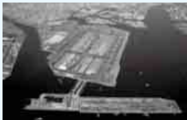
建設中の羽田空港D滑走路(写真手前)
