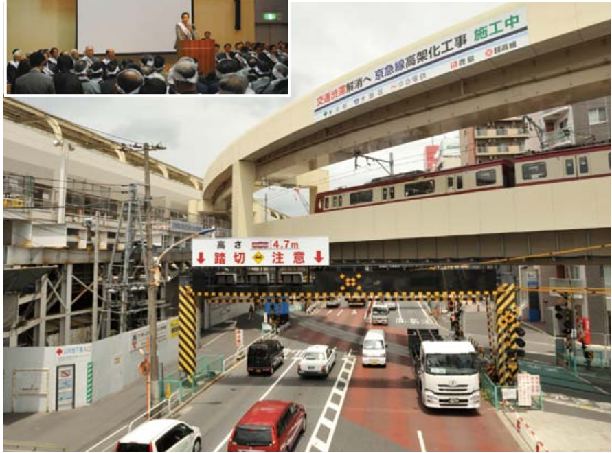
▼5月16日から上り線が高架化された京浜急行空港線
