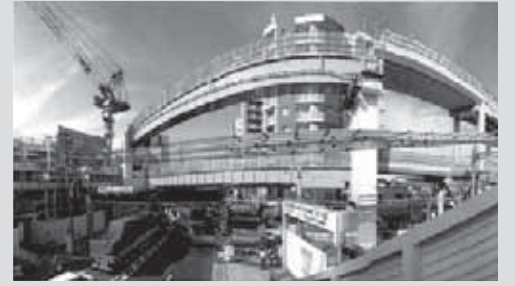
京浜急行連続立体交差事業(京急蒲田駅付近)
