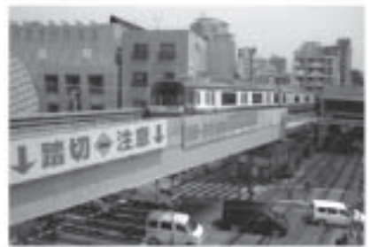
京浜急行上り線仮立体化
