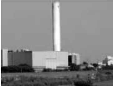
多摩川清掃工場
