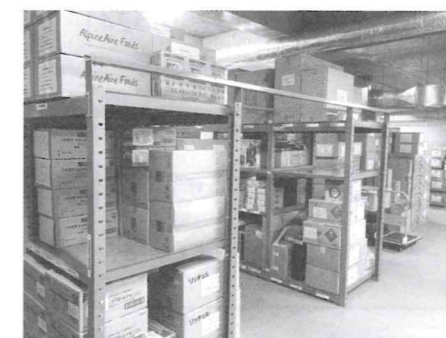
防災備蓄倉庫の様子(写真は大森七中)
