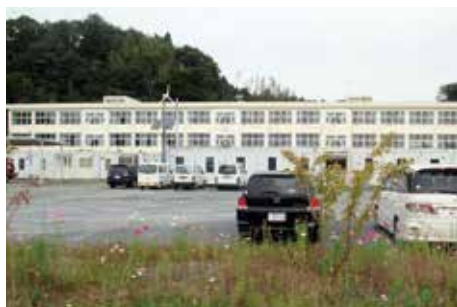
最初の避難所旧野蒜小学校建物
