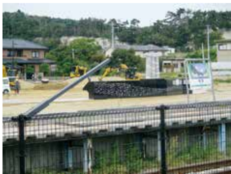
震災遺構として保存された 旧野蒜駅プラットホーム 後ろの石碑は建設中の震災 復興モニュメント (平成29年11月復興祈念 公園として整備)
