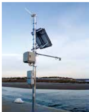
ソーラー発電による津波監視カメラ (小野専門員作成視察資料より)
