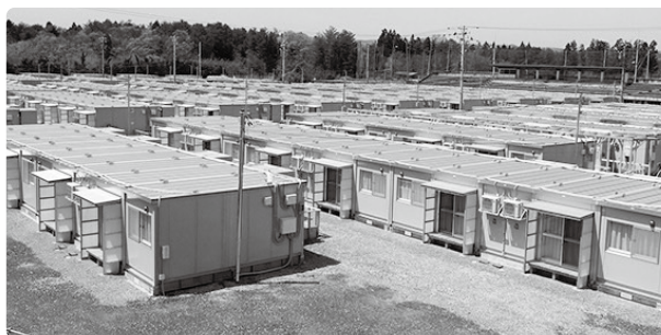
珠洲市の仮設住宅
