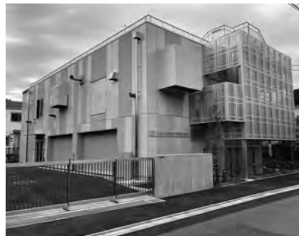
今春竣工した田園調布防水センター 排水ポンプ遠隔操作・非常用発電装置・監視カメラ等を備える (田園調布五丁目)
